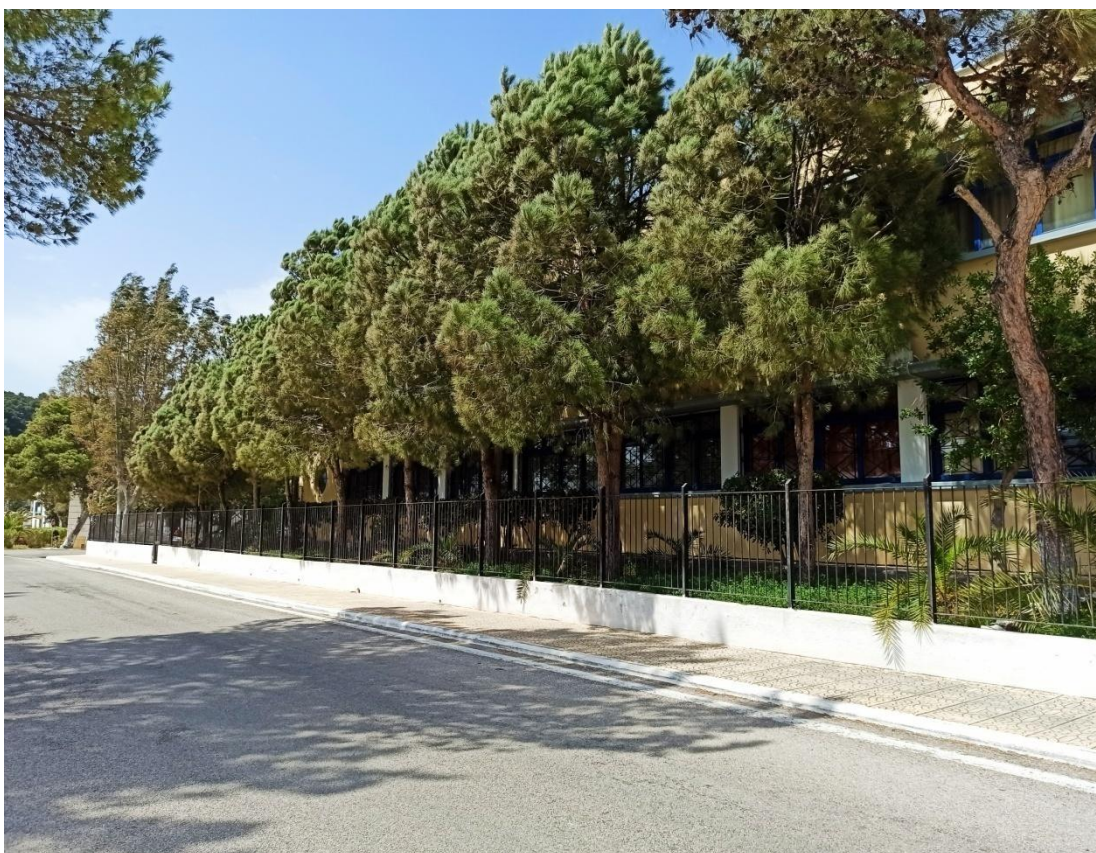
Εικ. 16. Νότια Εξωτερική Πλευρά
