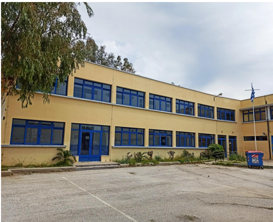
Εικ. 19. Ανατολική πτέρυγα του κτιρίου και τμήμα του προαυλίου. (Στον 1 ο όροφο διακρίνονται οι αίθουσες του Γυμνασίου ενώ στο ισόγειο οι αίθουσες του 1 ου ΕΠΑΛ Λέρου)
