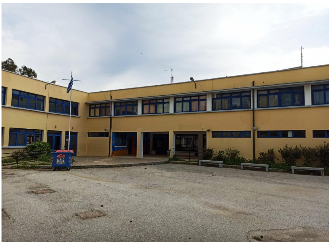
Εικ. 20. Νότια πτέρυγα κτιρίου και τμήμα του προαυλίου. (Στον 1 ο όροφο διακρίνονται οι αίθουσες του Γυμνασίου και του 1 ου ΕΠΑΛ Λέρου ενώ στο ισόγειο οι αίθουσες του 1 ου ΕΠΑΛ Λέρου)
