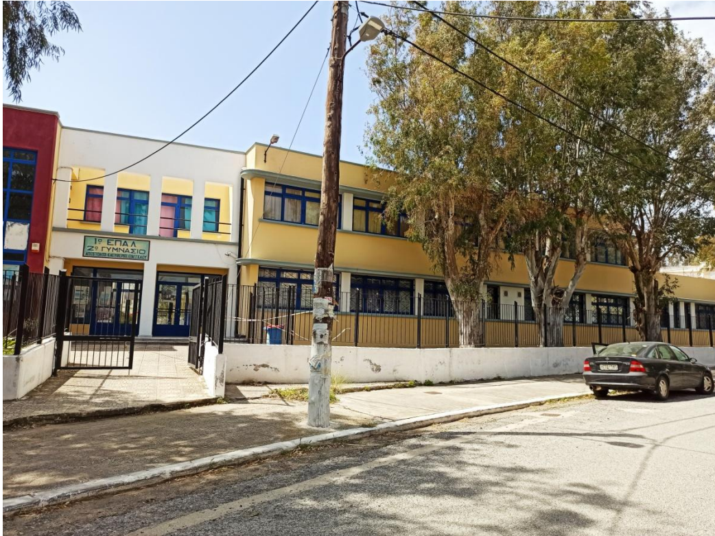
Εικ. 9. Εξωτερική ανατολική πλευρά
