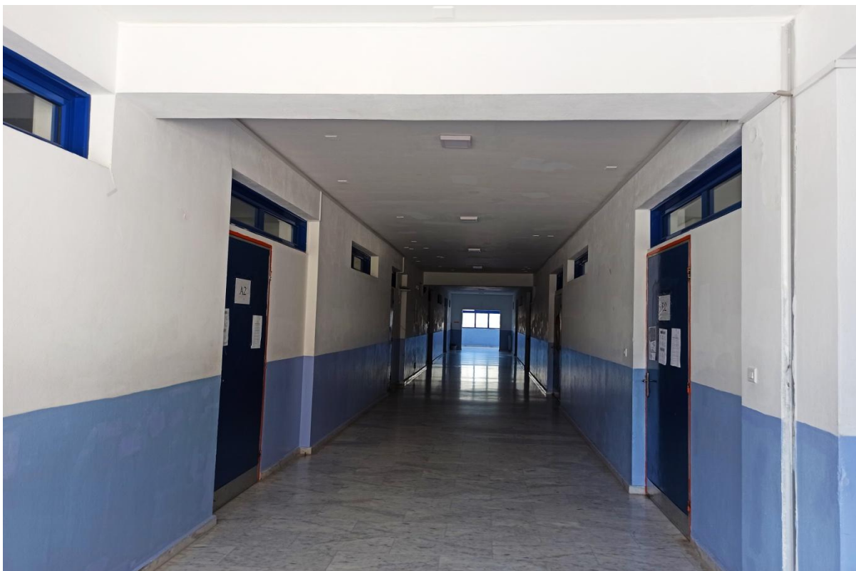
Εικ. 40. Εσωτερικός διάδρομος 1 ου ορόφου της νότιας πτέρυγας. (Στη δεξιά πλευρά φαίνονται τα Τμ. Α2 και Β1 και στην αριστερή το Τμ. Β2 και το εργαστήριο Η/Υ και Φυσικών Επιστημών). Στο βάθος διακρίνονται οι αίθουσες του 1 ου ΕΠΑΛ Λέρου)
